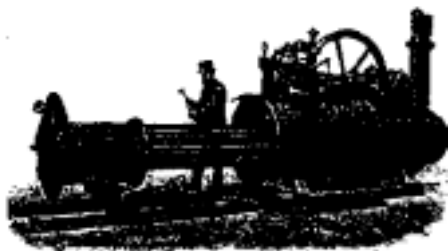
Трубчатый котел с выдвигными трубками
